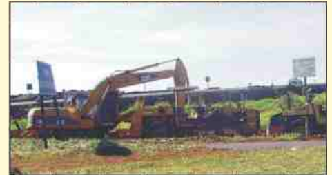
Obras do PAC movimentam Construção Pesada
